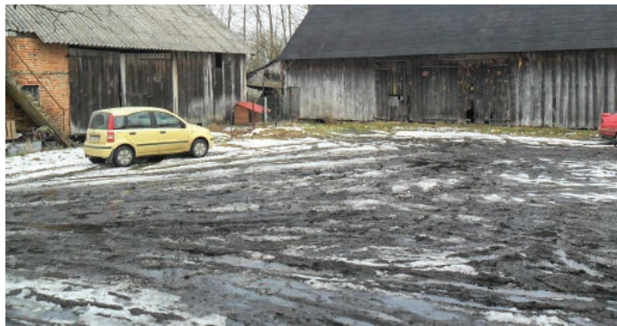
Foto KRUS: Zły stan nawierzchni podwórza.
